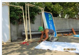
Construction de douches et de toilettes
